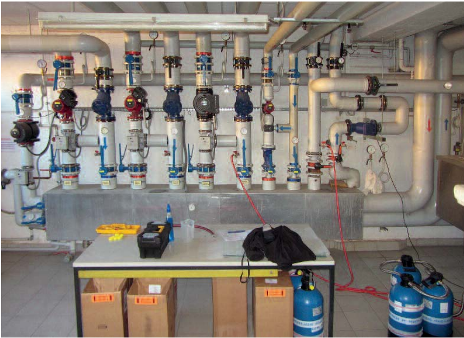
Bilder 6 + 7 • Insgesamt 3 Stück permasoft PT-PS21000IL wurden – in Reihe geschaltet – an den Heizungsverteiler angeschlossen.
