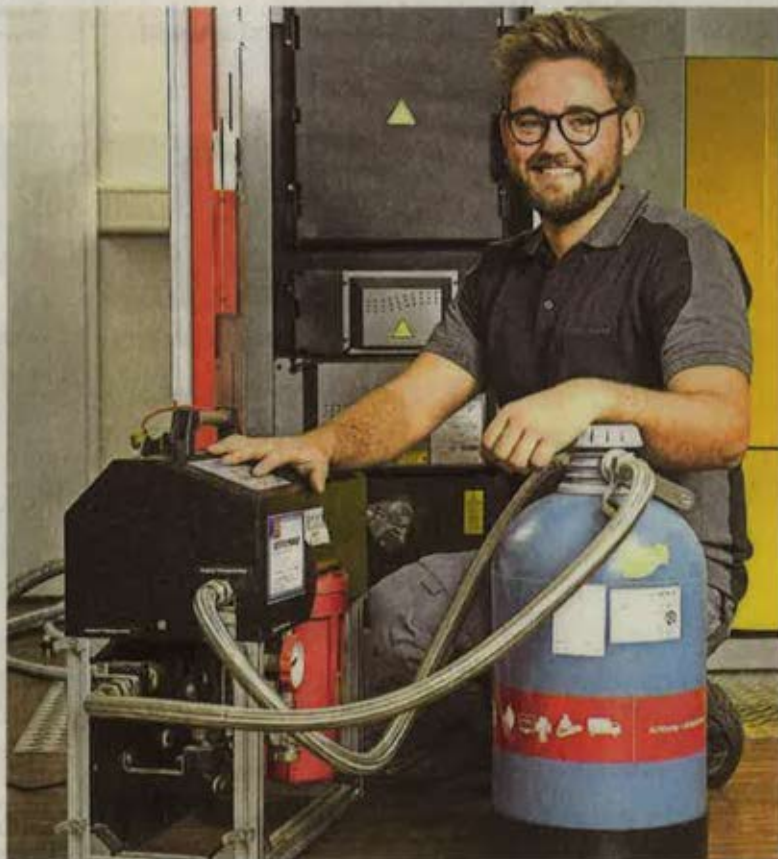
Vorsicht bei Öl und Gas: Janek Schlittenhardt prüft im Familienbetrieb als Anlagenmechaniker Heizungen bei den Kunden vor Ort.
